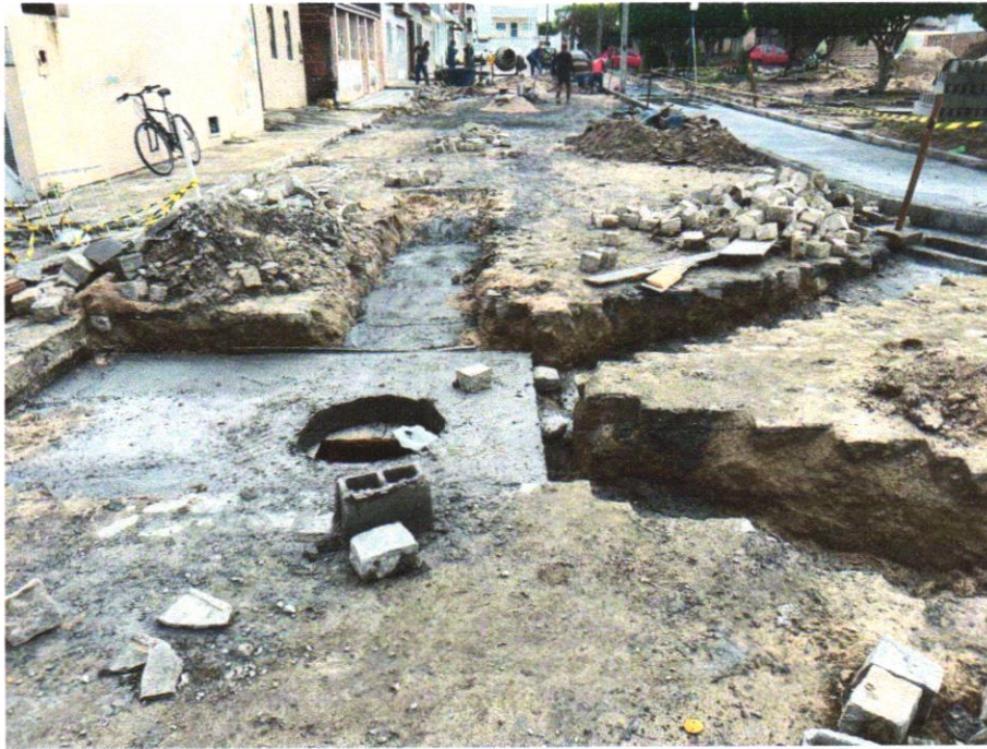
Foto 03 – ESCAVAÇÃO MANUAL DE VALA COM PROFUNDIDADE MENOR OU IGUAL A 1,30 M
