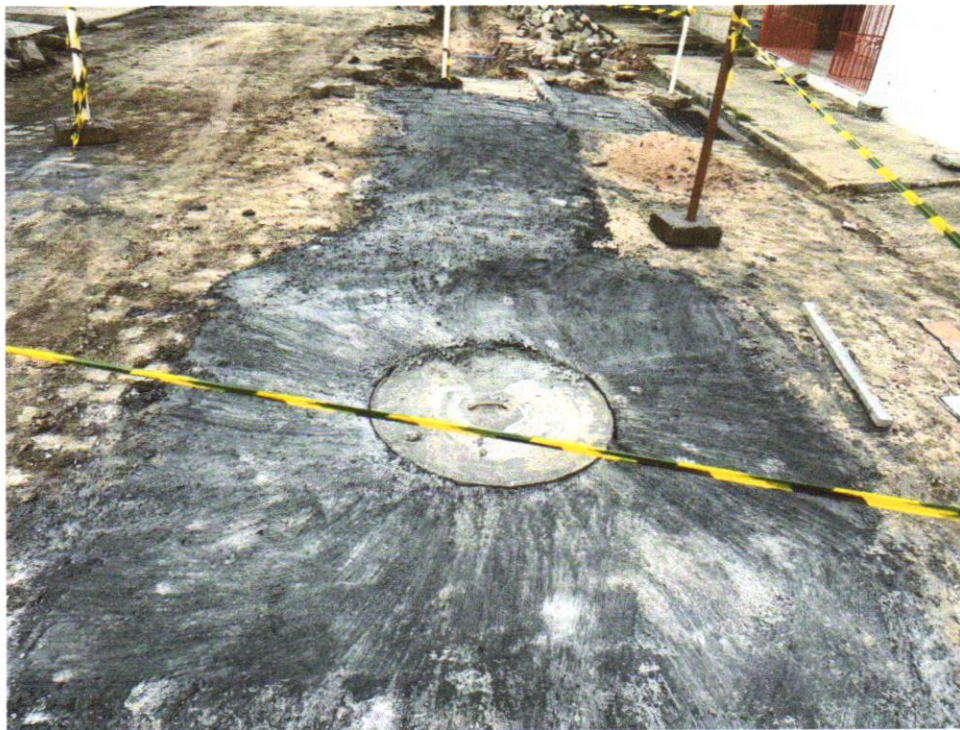
Foto 11 – CONCRETO FCK = 25MPA, TRAÇO 1:2,3:2,7 (EM MASSA SECA DE CIMENTO/ AREIA MÉDIA/ BRITA 1) - PREPARO MECÂNICO COM BETONEIRA 600 L. AF_05/2021
