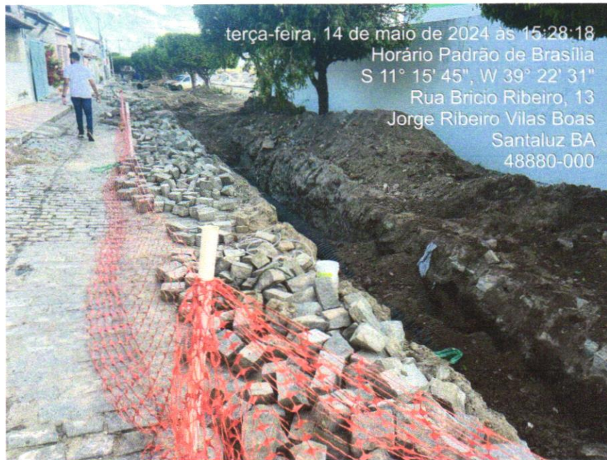
Foto 01 - Tapume de proteção em tela de polietileno h=1,20 com bloco de concreto
