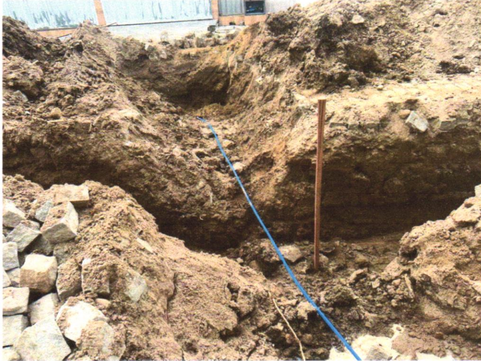
Foto 05 - ESCAVAÇÃO MECANIZADA ATÉ 1,50M EM MATERIAL DE 1º CATEGORIA PARA ABERTURA DE CORTE PARA ATERRO, SEM BOTA FORA
