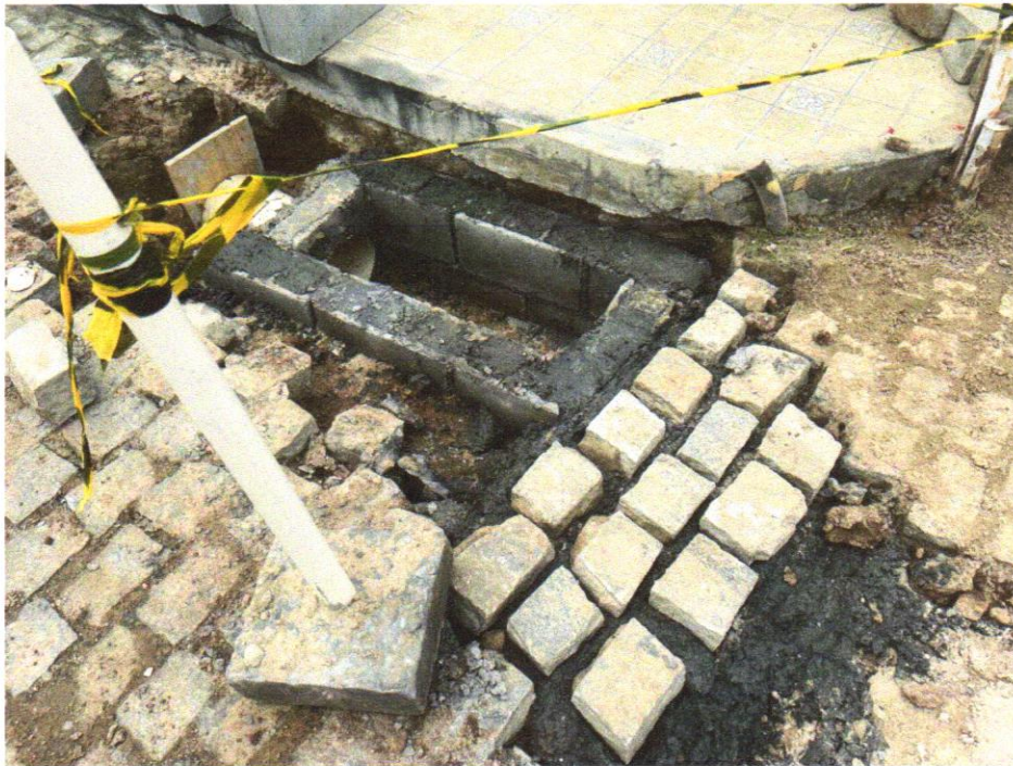
Foto 09 - ALVENARIA DE VEDAÇÃO DE BLOCOS VAZADOS DE CONCRETO DE 9X19X39CM (ESPESSURA 9CM) DE PAREDES COM ÁREA LÍQUIDA MAIOR OU IGUAL A 6M 2 COM VÃOS E ARGAMASSA DE ASSENTAMENTO COM PREPARO MANUAL. AF_06/2014
